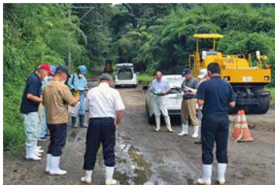
工事の進捗状況等の説明を受ける常勤役員
